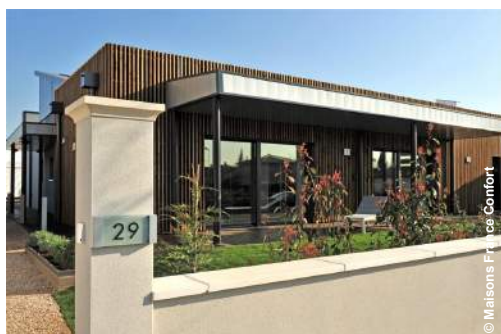
Maison à énergie positive à Saint-Priest
